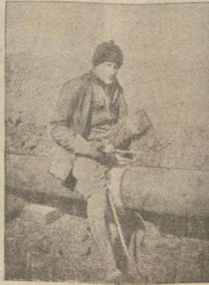
Döşenmiş borulara kaynak yapıyor. Demir borular döşenirken
